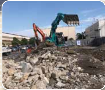
修理場の解体▼
