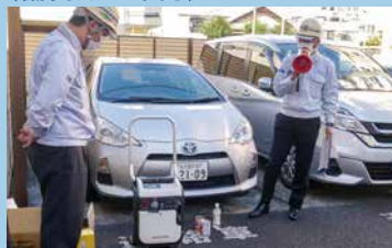
緊急時用に備えてある自家発電機の操作方法を確認しました
